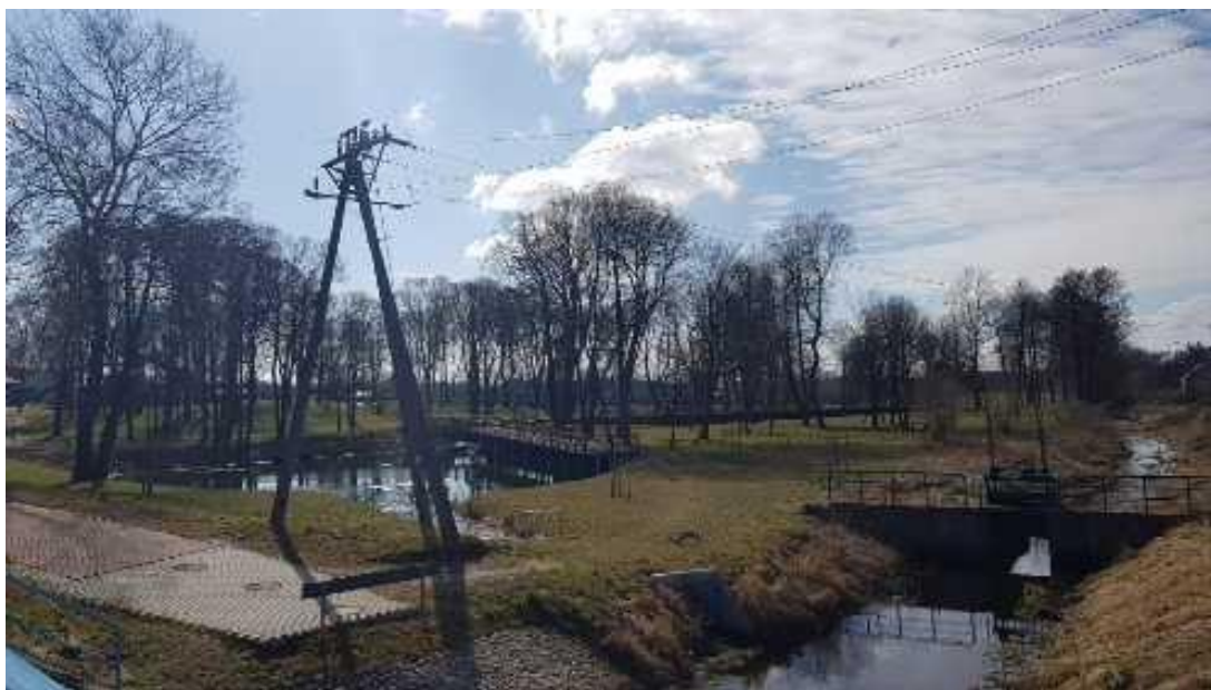
Fotografia nr 74. Widok na dawny zespół dworsko – ogrodowy w Zabłudowie.
