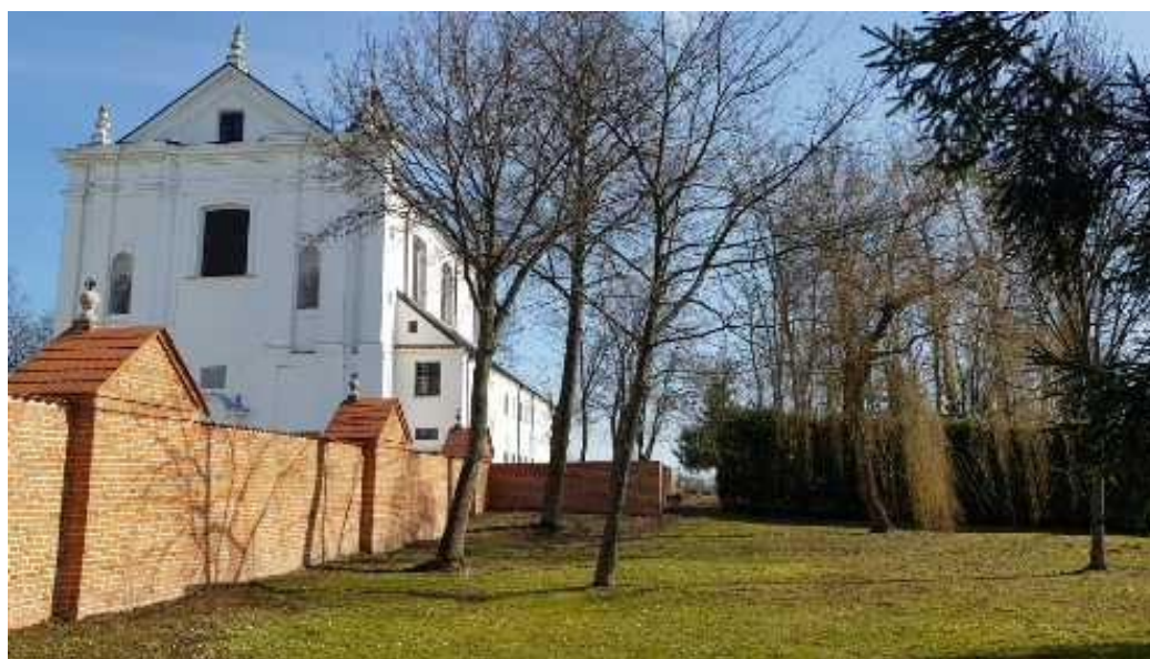
Fotografia nr 14. Widok na miejsce po budynku klasztoru Ojców Reformatorów przy kościele parafialnym, obecnie pod wezwaniem Świętego Józefa Oblubieńca i Świętego Antoniego Padewskiego w Boćkach. Wykonano dnia 3 kwietnia 2024 roku, autor Karol Straczyński.
