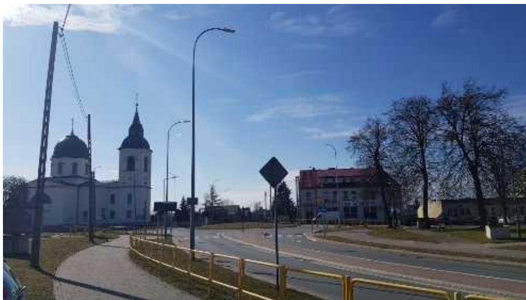
Fotografia nr 69. Widok na cerkiew parafialną pod wezwaniem Zaśnięcia Najświętszej Marii Panny od strony pierzei północnej rynku w Zabłudowie. Wykonano dnia 3 kwietnia 2024 roku, autor Karol Straczyński.
